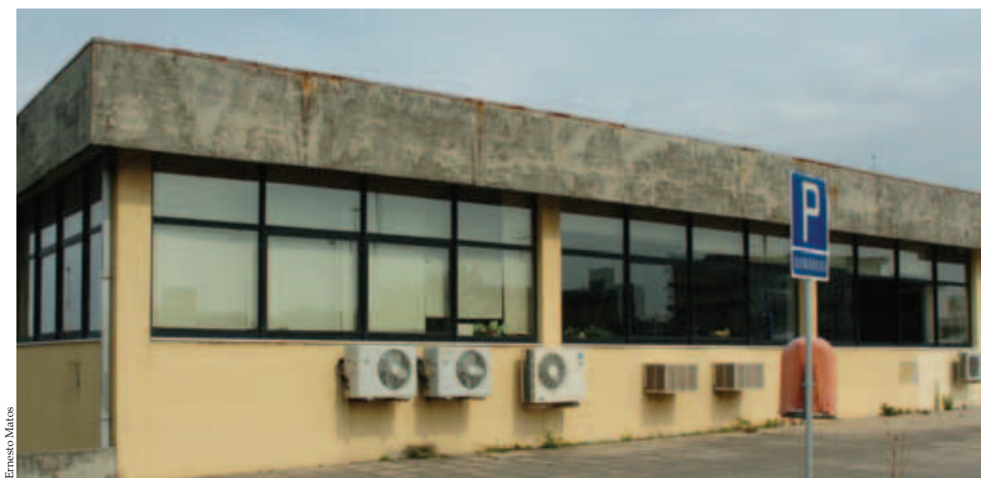
Vista exterior do edifício da Alfândega do Freixeiro
